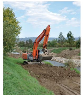
Einerseits wird dabei der Durchfluss unmittelbar bei der Volksschulbrücke verbessert und andererseits wird durch den Einbau von Buhnen der Querschnitt der Melk verbessert. Die im vergangenen Jahr bei der ehemaligen Eisenbahnbrücke errichteten Buhnen wurden von der heimischen Bevölkerung bereits im heurigen Sommer sehr intensiv als Naherholungsoase genutzt.
