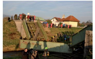
Trotz intensiver Vorbereitungen durch das Bundesheer der Melker Pioniere war es nicht möglich, die Eisenbahnbrücke unmittelbar mit der Sprengung zum Einsturz zu bringen. Erst mit Unterstützung eines Bergepanzers, welcher die Brücke seitlich wegzog, brach sie plangemäß ein. Natürlich wäre das Einstürzen vor laufenden Kameras allen zu wünschen gewesen, aber mitten im Siedlungsgebiet war natürlich besondere Vorsicht geboten. Die
